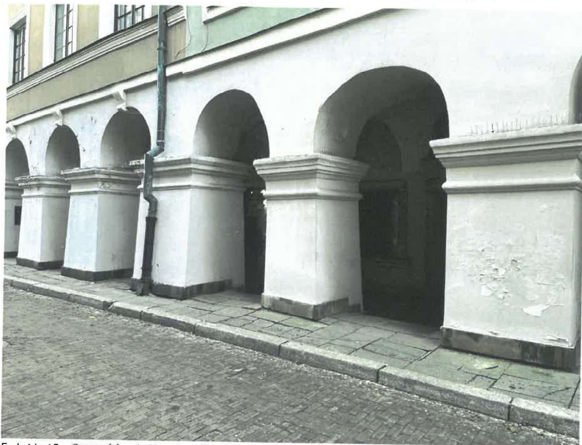
Fot. Nr 45 – Zamość, ul. Staszica 35. Widoczne zniszczenia filarów podcieni.
