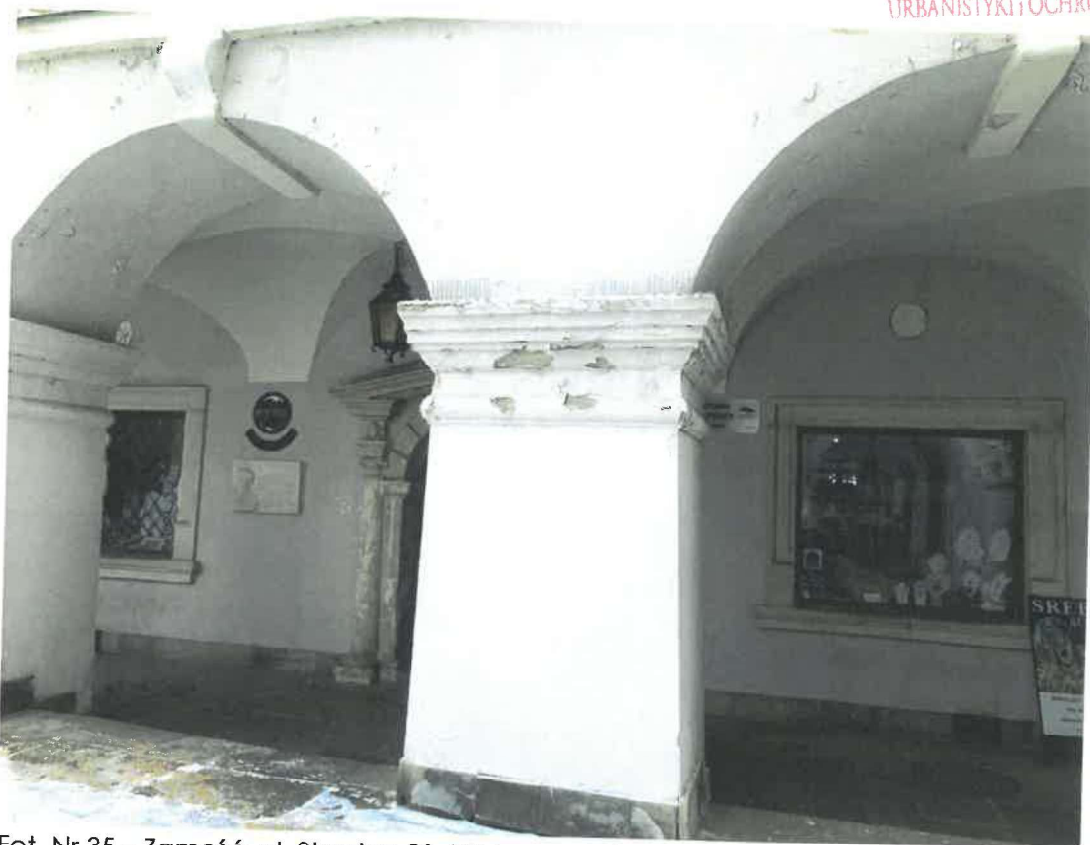
Fot. Nr 35 – Zamość, ul. Staszica 31. Widoczne zniszczenia filarów podcieni.
