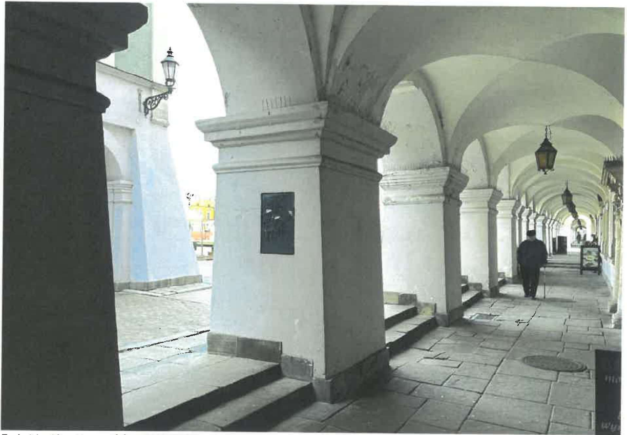
Fot. Nr 43 – Zamość, ul. Staszica 33. Widoczne zniszczenia impostów filarów.
