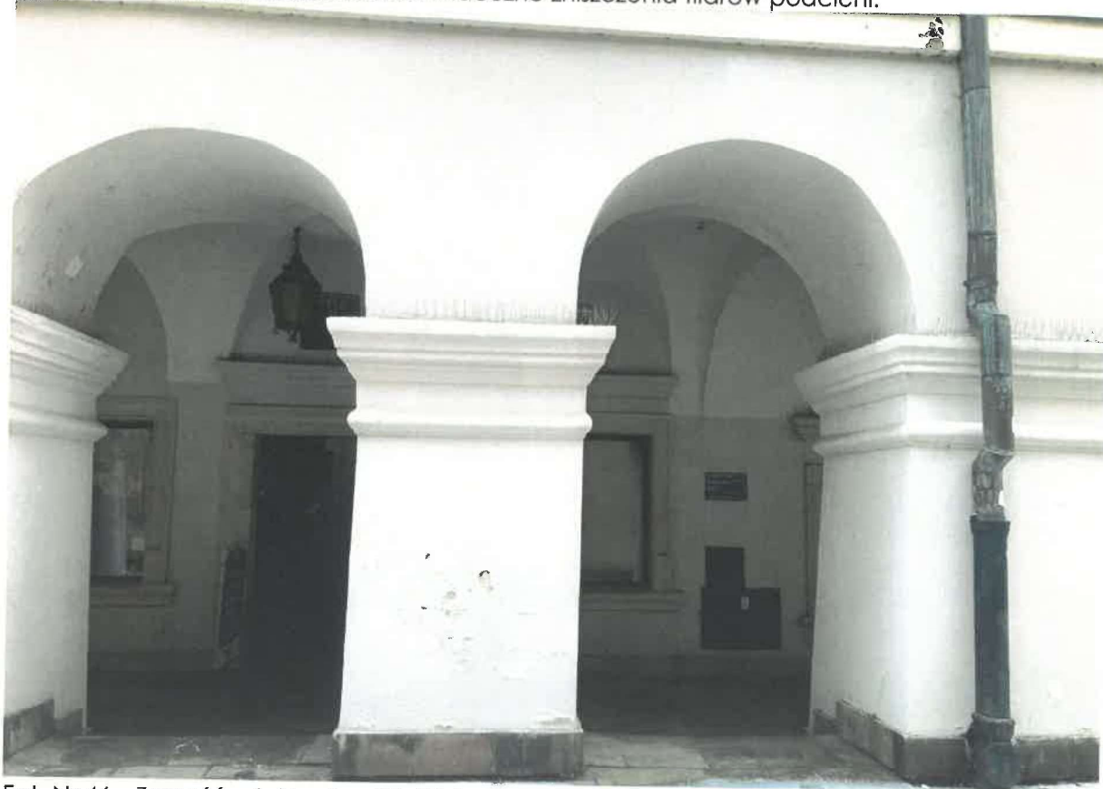
Fot. Nr 46 – Zamość, ul. Staszica 35. Widoczne zniszczenia filarów podcieni.
