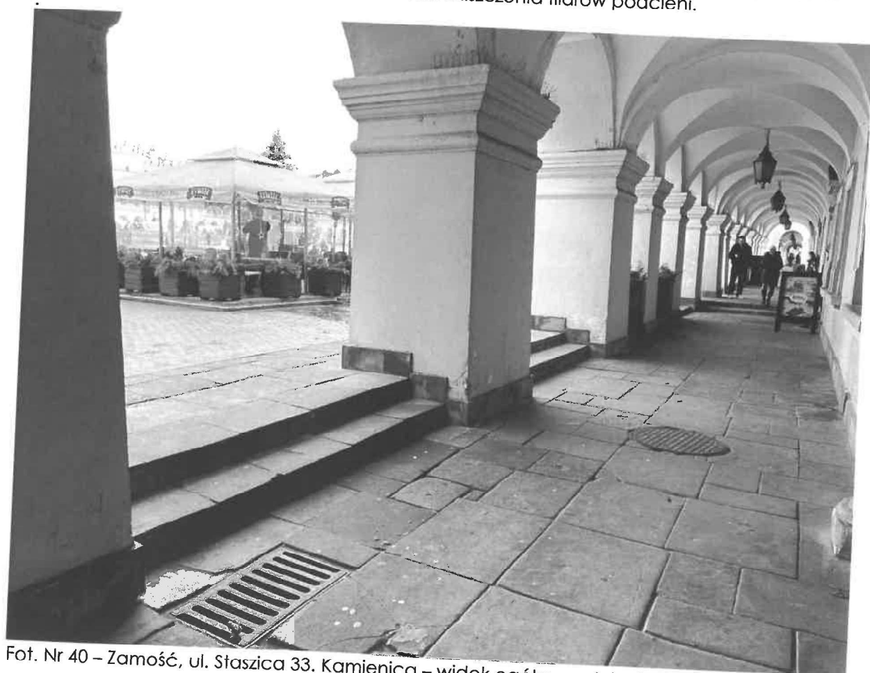
Fot. Nr 39 – Zamość, ul. Staszica 33. Widoczne zniszczenia filarów podcieni.
