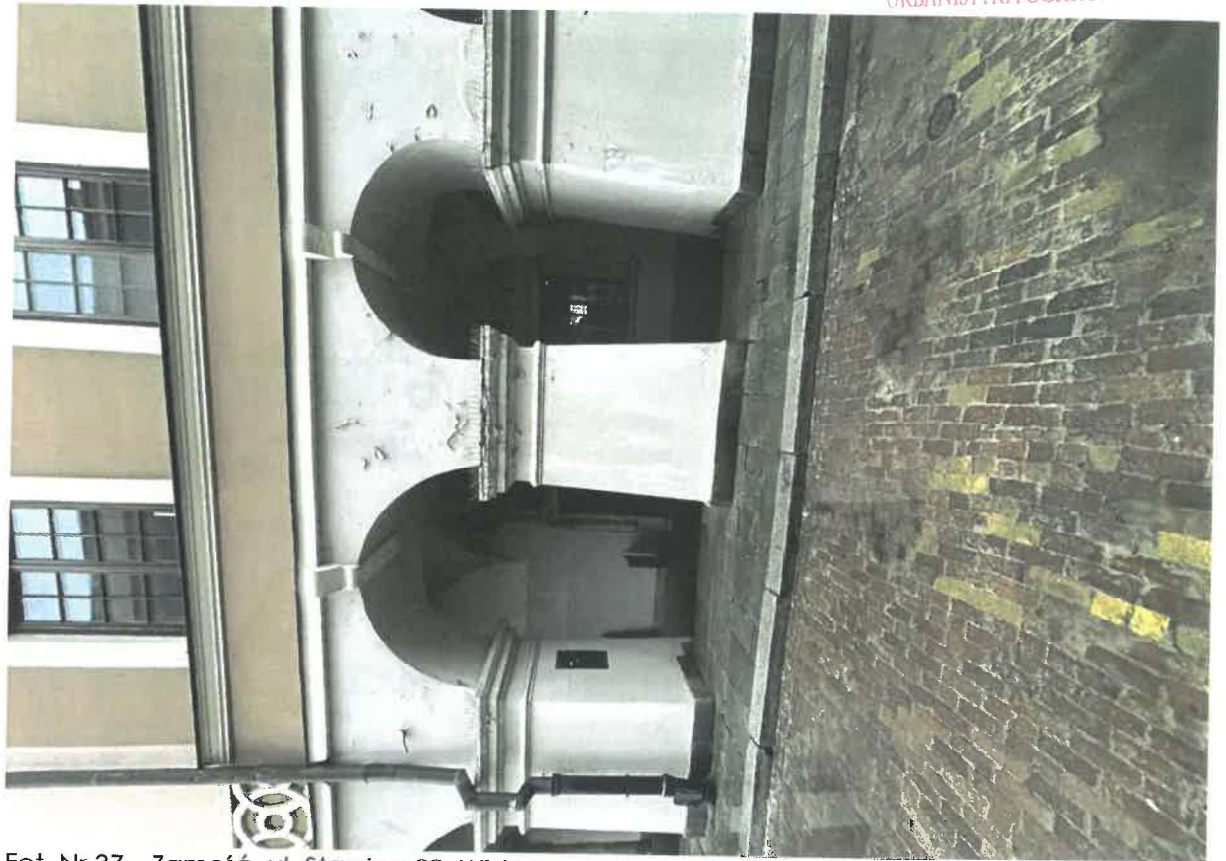
Fot. Nr 37 – Zamość, ul. Staszica 33. Widoczne zniszczenia filarów podcieni.
