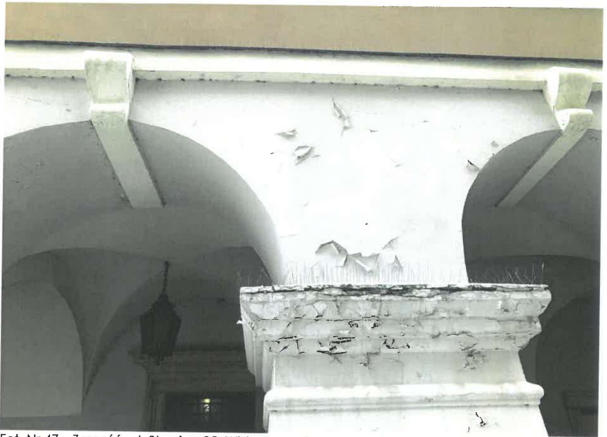
Fot. Nr 47 – Zamość, ul. Staszica 35. Widoczne zniszczenia impostów filarów.
