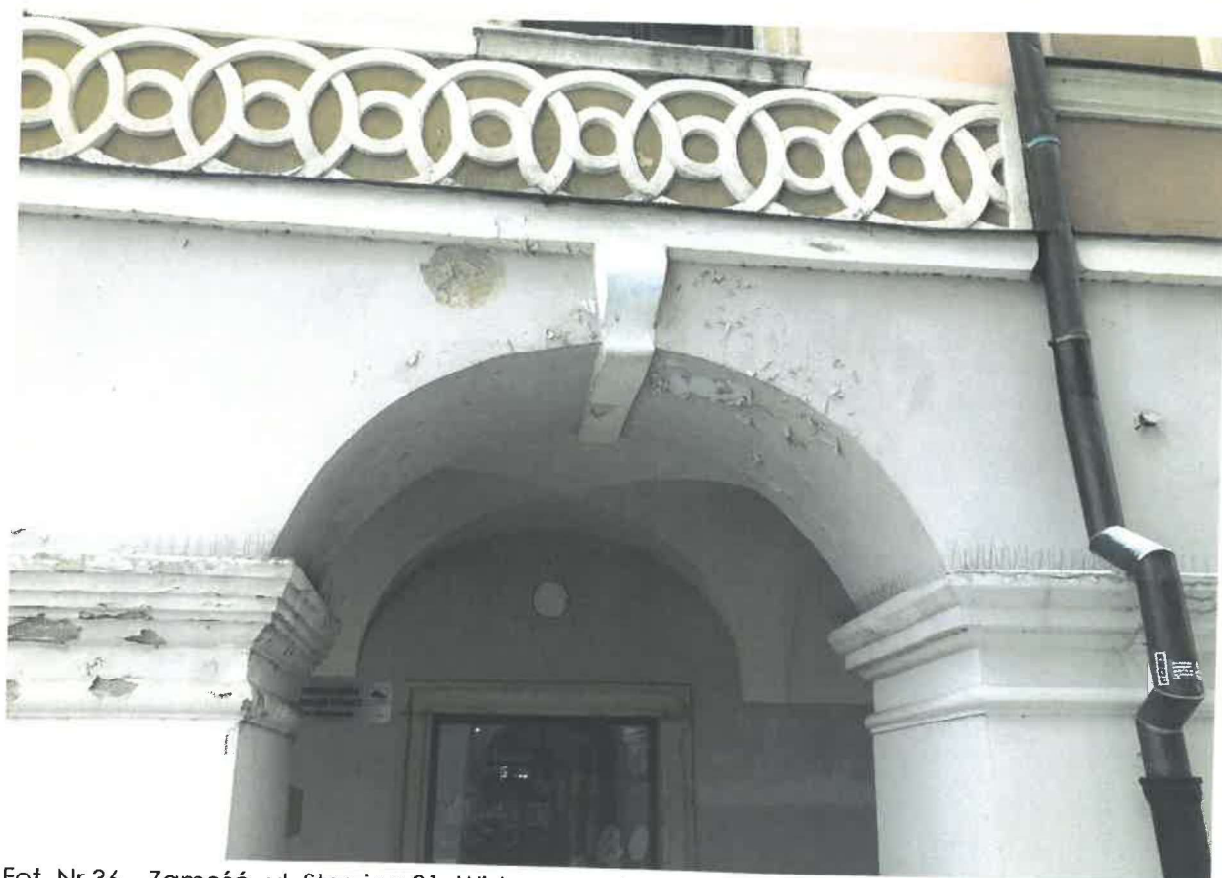
Fot. Nr 35 – Zamość, ul. Staszica 31. Widoczne zniszczenia filarów podcieni.
