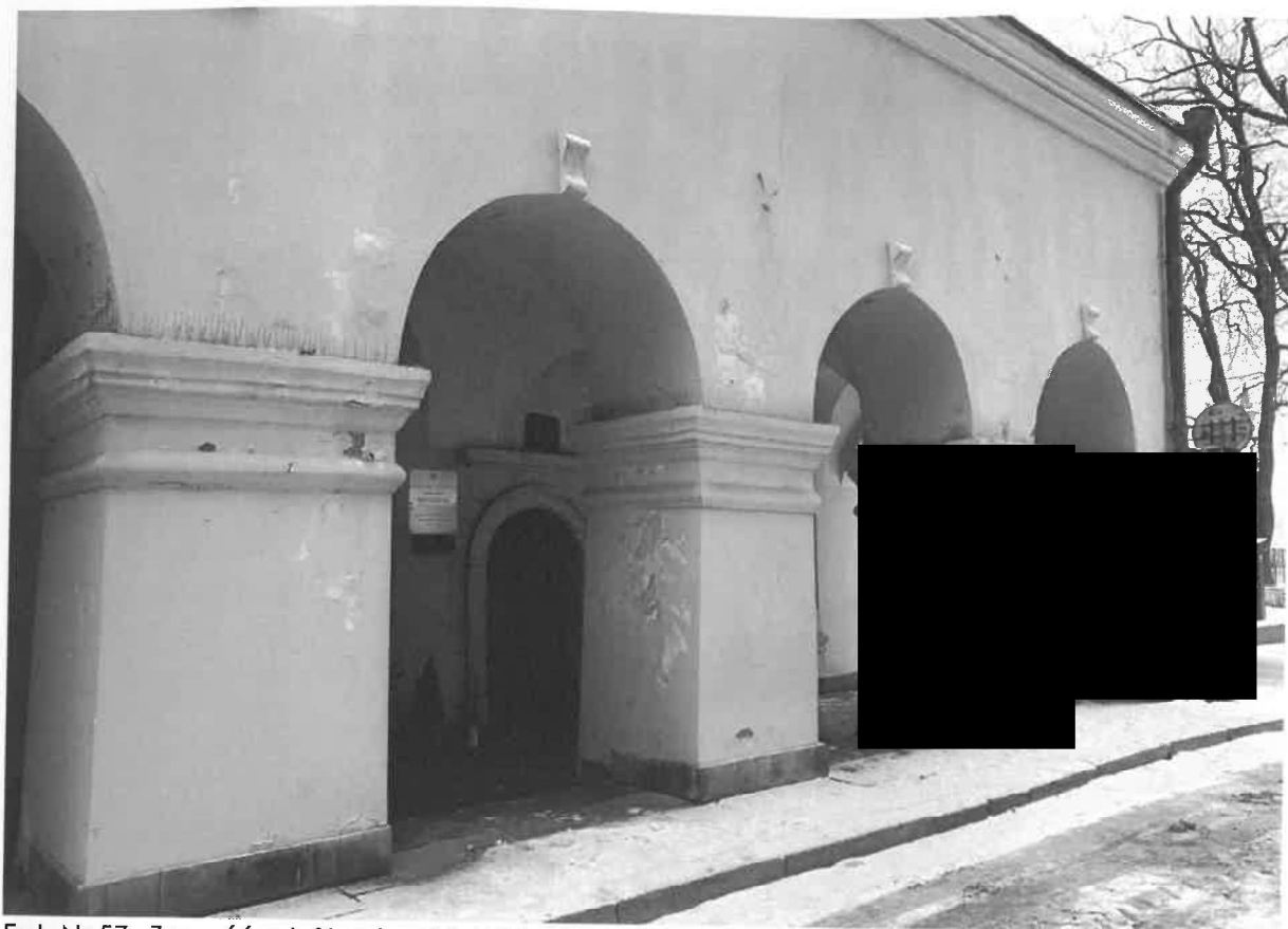
Fot. Nr 57– Zamość, ul. Staszica 39. Widok ogólny podcieni. Widoczne zniszczenia wypraw filarów.
