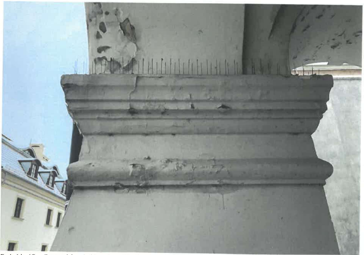
Fot. Nr 60 – Zamość, ul. Słazica 39. Przykład zniszczeń impostów filarów
