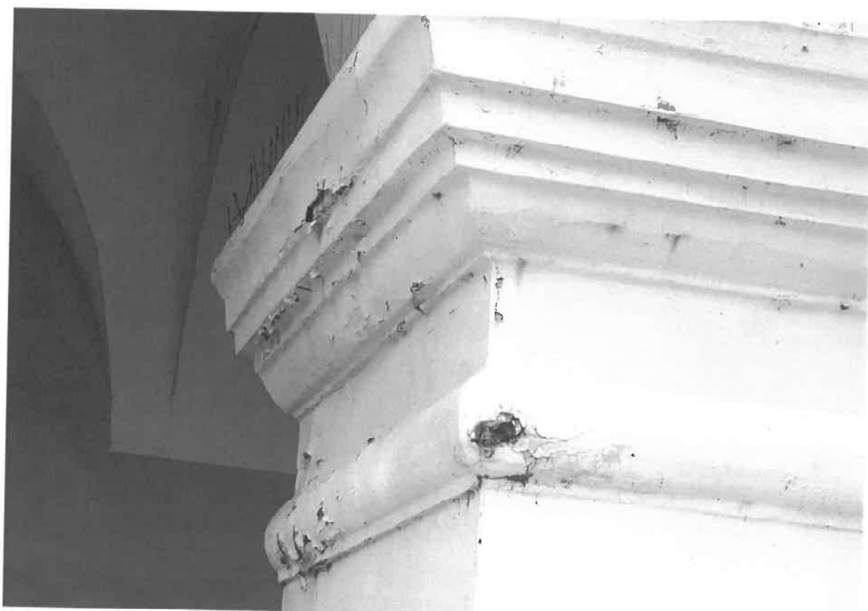
Fot. Nr 28 – Zamość, ul. Staszica 29. Zniszczone profilowanie impostów.
