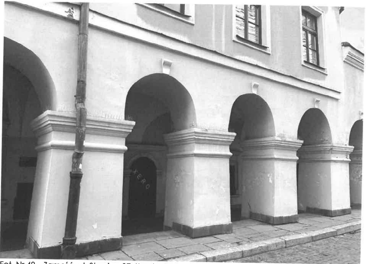
Fot. Nr 49 – Zamość, ul. Staszica 37. Kamienica – widok ogólny podcieni. Widoczne zniszczenia filarów.
