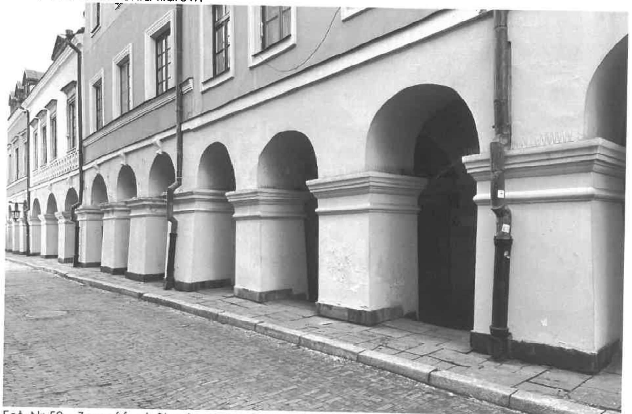
Fot. Nr 50 – Zamość, ul. Staszica 37. Kamienica – widok ogólny podcieni. Widoczne zniszczenia filarów.
